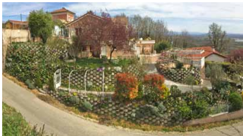
▲ Krajinotvorné užití betonových prvků ATALUS ve svažitém terénu – vytvoření teras přispívá k efektivnímu využití pozemku
