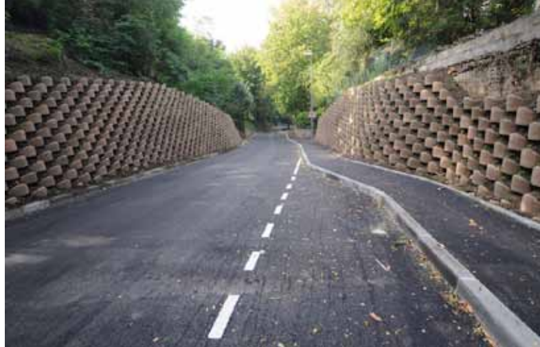
▲ Příklad výhodného užití prvků ATALUS při řešení zářezu komunikace do okolního terénu
