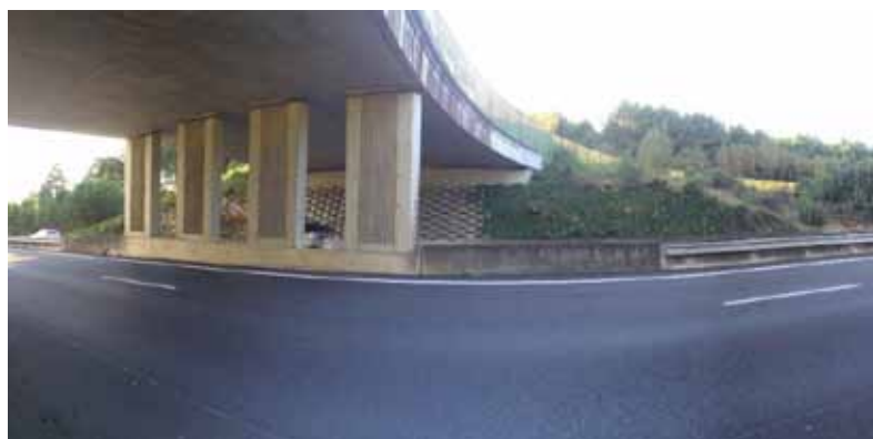
▲ Užití prvků ATALUS v dopravní infrastruktuře – zkracuje délku díla a přispívá tak k jeho lepší ekonomice
